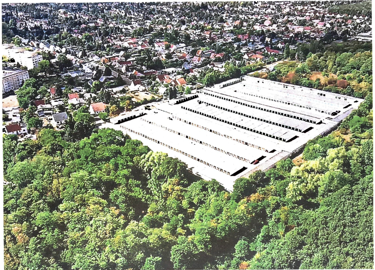
Die riesige Dachfläche des Garagenhofs Mockau-Ost eignet sich ideal zur Solarstromerzeugung.
